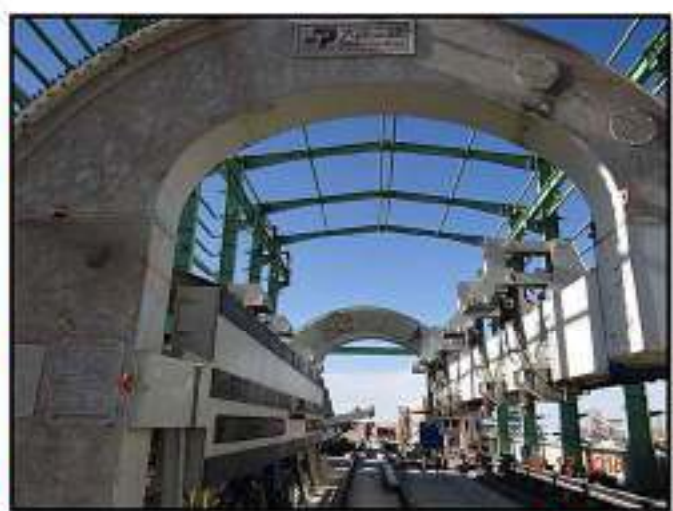
نصب تجهیزات واگن برگردان
