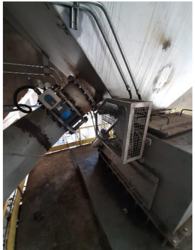
راه اندازی و استارت Hydraulic Valve های مربوط به کوره B
