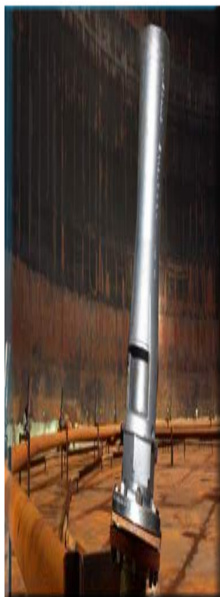
شکل ۳: نمونه مخزن مجهز به جت میکسر سیال.
